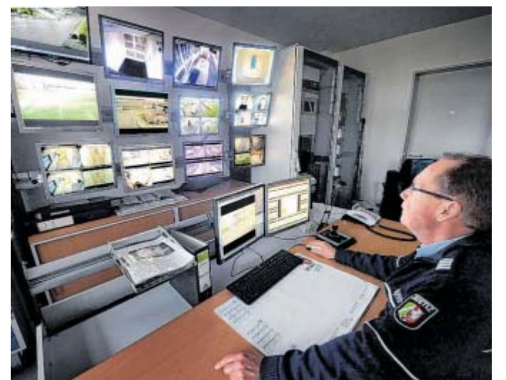
Überwachung: Der Justizvollzugsamtsinspektor Rolf Bettenbrock kontrolliert die Aufnahmen im Monitorraum der Sicherheitszentrale.
